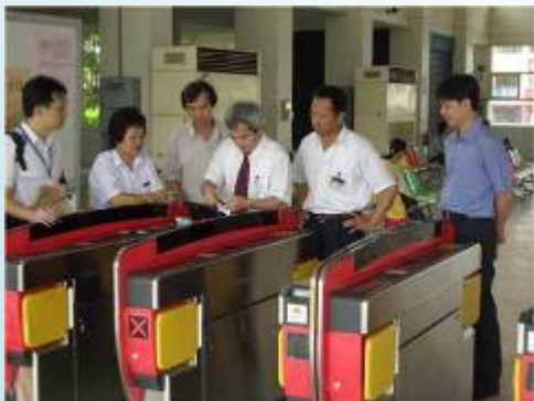
台鐵自動閘門系統
